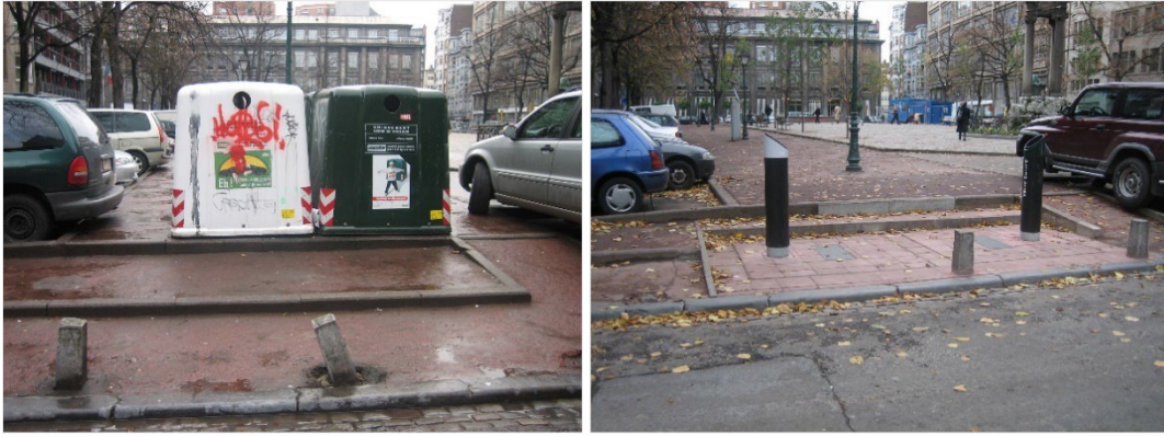
Place Saint Paul (Quartier Centre) : avant/après l'installation de bulles à verre enterrées
