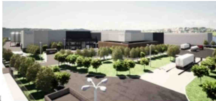
La construction de l'usine se terminera en fin d'année. Sa mise en service est programmée en janvier 2023.
