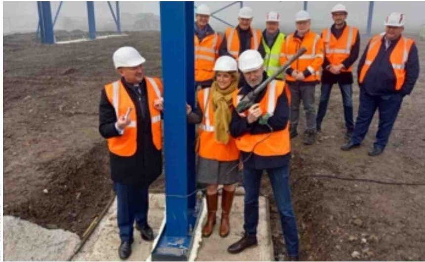
Les ministres Borsus et Tellier, et le bourgmestre Paul Magnette, ont procédé à l'inauguration du chantier. Dans une évidente bonne humeur...
