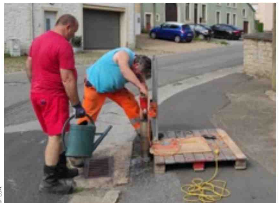
Ce sont les ouvriers communaux qui placent les macarons en pierre de lave « Ici commence la mer », à proximité de plusieurs avaloirs.
