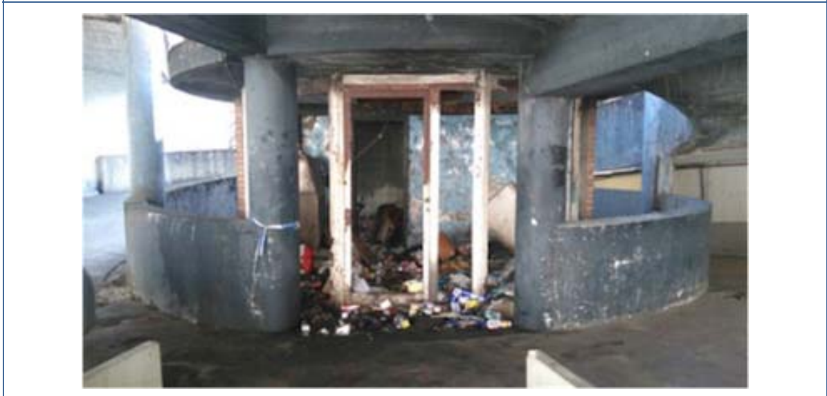
Oben: Zustand des Verfalls, der einen oder mehrere Abfälle erzeugte.
